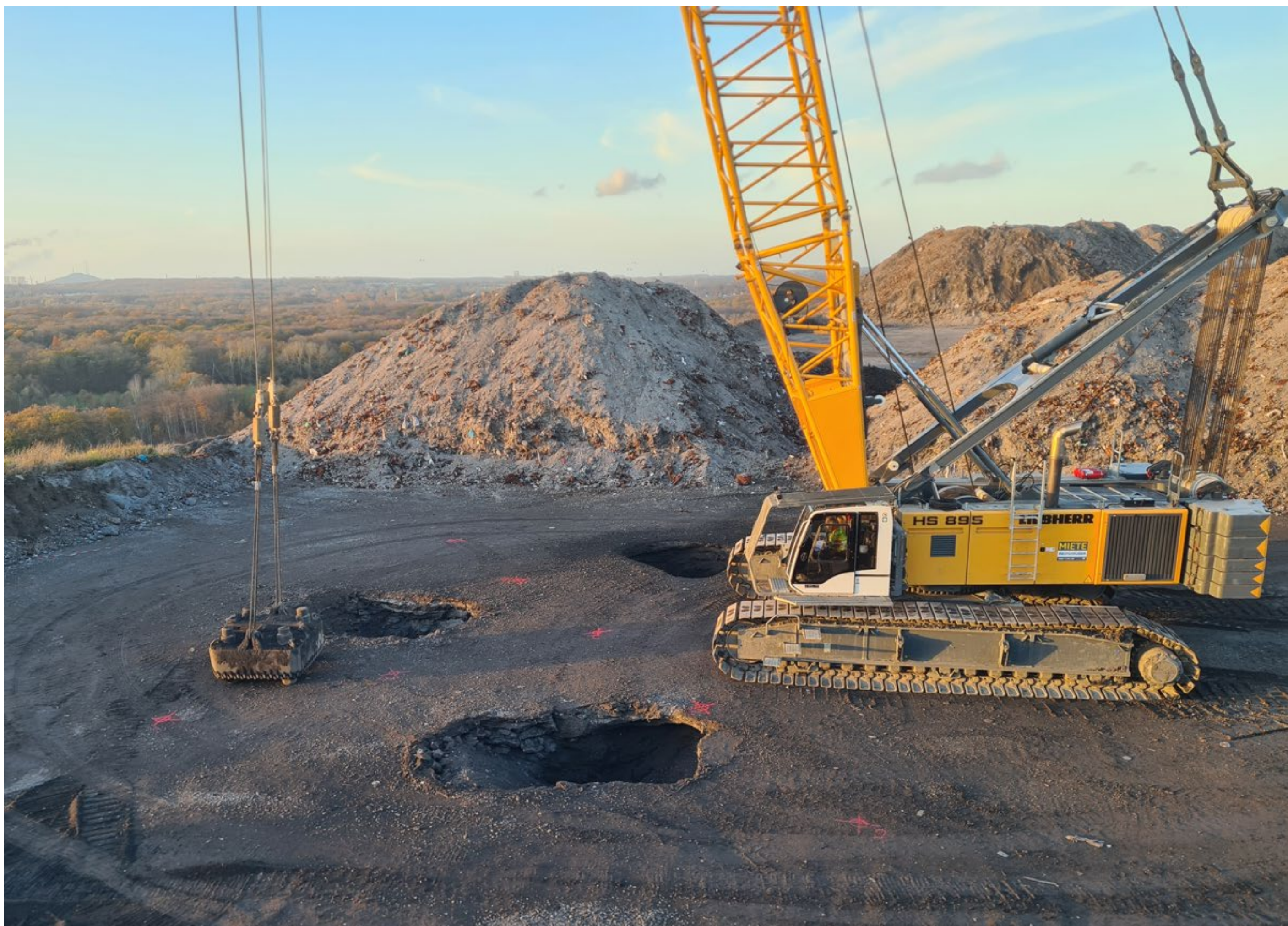
Bild: Institut für Geotechnik an der HTWK Leipzig
